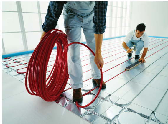
Für die notwendige Wärmeleitfähigkeit sorgen Polystyrol- Dämmelemente, die vollflächig mit Aluminium verkleidet sind. Selbst an den Umlenkelementen geht hier keine Wärme verloren. (Foto: JOCO)
