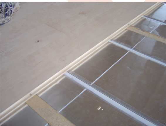
Da der Aufbau des KlimaBodens TOP 2000 nass oder trocken erfolgen kann, lässt sich dessen Aufbauhöhe maximal niedrig halten. Das ist in Altbauten oft entscheidend. (Foto: JOCO)
