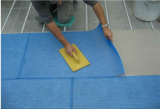
Das biegsame Blanke PERMAT Vlies sorgt für eine dauerhaft funktionssichere Entkopplung zwischen Untergrund und Oberbelag sowie für eine optimale Lastschichtverteilung. (Foto: JOCO)
