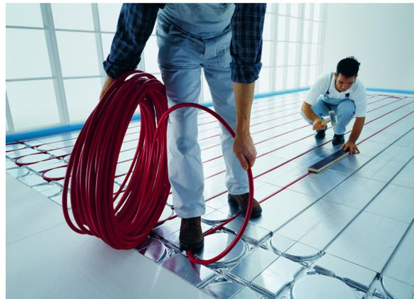
Beim JOCO KlimaBoden TOP 2000 liegen die Rohre in einer Dämmschicht aus Polystyrol, NEOPOR oder ökologischem Holzfasermaterial. Die Systemplatten mit NEOPOR beispielsweise sind nur 25 Millimeter dick und begünstigen die geringe Aufbauhöhe. (Foto: JOCO)
