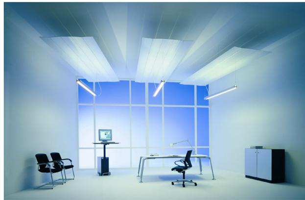
Für das Arbeitsklima im Büro wichtig: Es gibt keine Geräusch- und Geruchsbelästigungen. Die Strahlung erwärmt oder kühlt die umgebende Luft ohne Turbulenzen und Zugerscheinungen.
