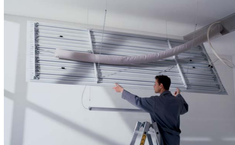
Foto oben: werkzeugloses Abklappen für die Reinigung nach VDI Richtlinie 6022
