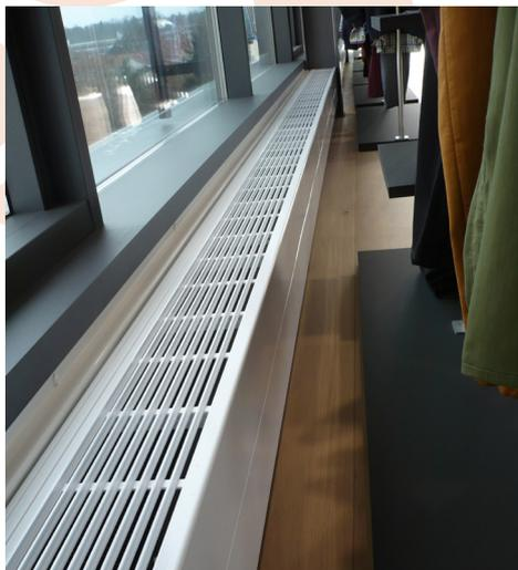
Die robuste StepLine-Verkleidung ist begehbar und kann als Stufe benutzt werden – etwa, wenn ein Zugang zu einer Dachterrasse besteht. (Foto: JOCO)
